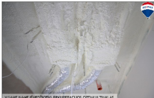
VISAME NAME IŠVEDŽIOTAS REKUPERACIJOS ORTAKIŲ TINKLAS
