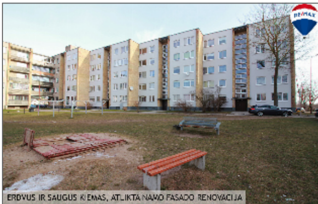
ERDVUS IR SAUGUS KIEMAS, ATLIKTA NAMO FASADO RENOVACIJA
