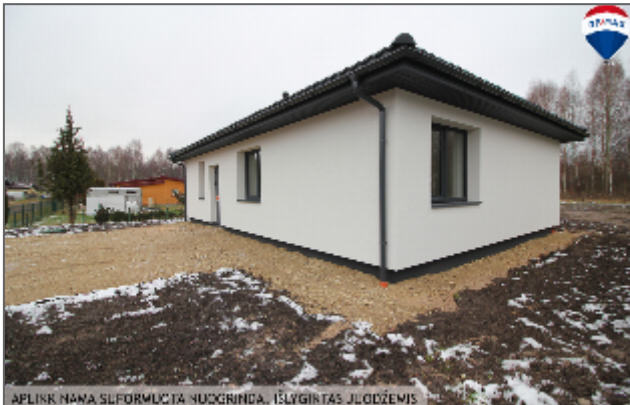
APLINK NAMŲ SUFORMUOTA NUOGRINDA, IŠLYGINTAS JUDŽEMIS
