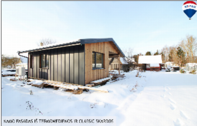
NAMO FASADAS IŠ TERMOVODINIŲ IR CLASSIC SKARDOS
