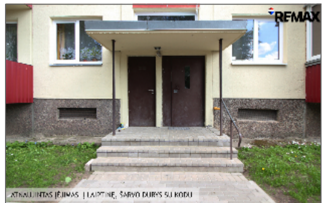
NALLAI SUTVARKYTI KIEMAI, IŠASPALTUOTOS GATVĖS, TVARKINGAS NAMO FASADAS
